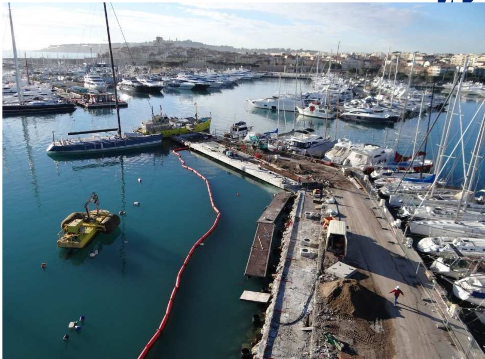
Dossier de Presse - Rénovation môle Nord - Novembre 2014
